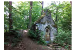
Hochwasserbehälter nördlich des Johannistals
